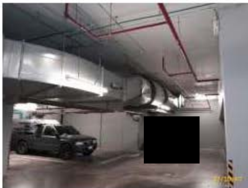
ระบบระบายอากาศพื้นที่จอดรถ
